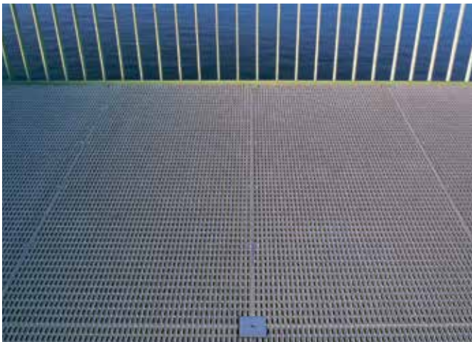
GFK-Gitterroste als Fußgängerbrückenbelag
