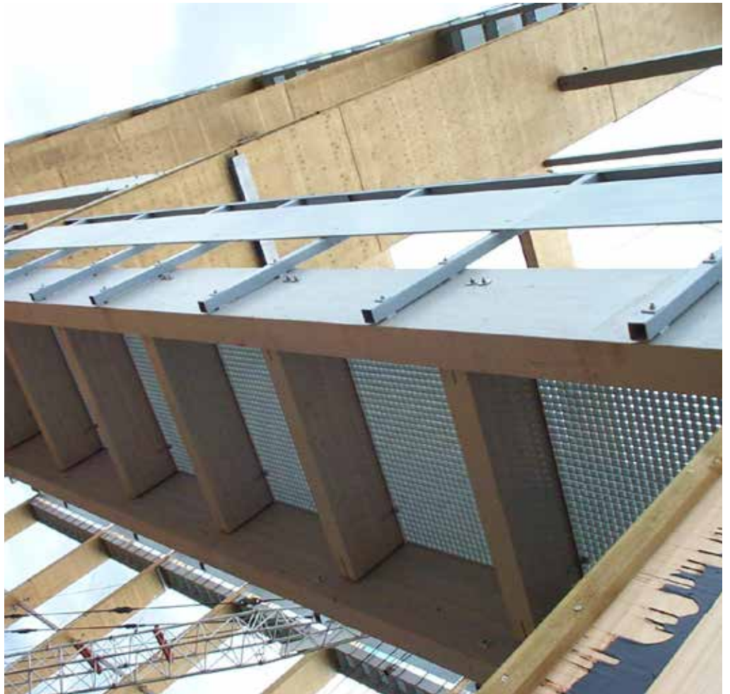
Oben: Antimagnetfeld: Lediglich Holz und GFK wurden verwendet
